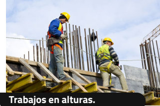
Trabajos en alturas.
