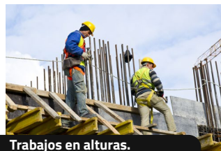
Trabajos en alturas.
